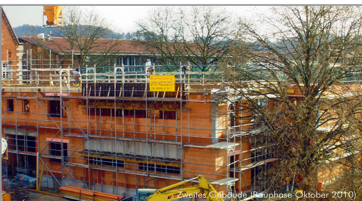
Zweites Gebäude (Bauphase Oktober 2010)
